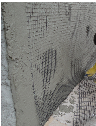
Figura 6.7: Aplicação da malha de fibra de carbono (site S&P)
