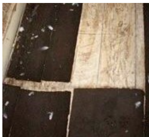
(b) Pavimento interior revestido com tábuas de soalho e alcatifa (Gomes, 2011)
