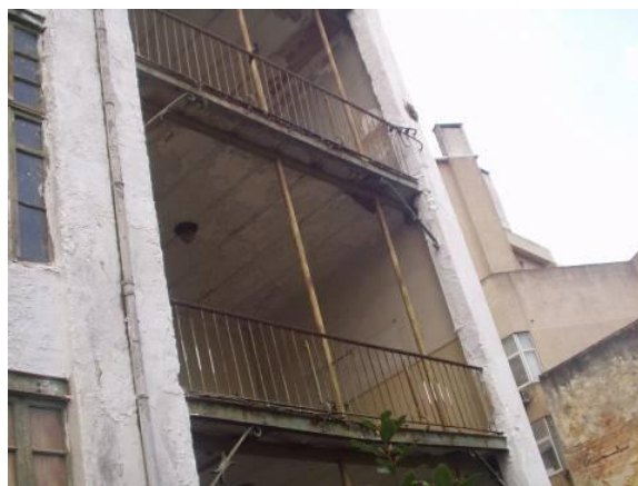
(b) Terraço apoiado em elementos metálicos
