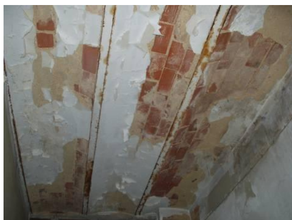
(a) Pavimento do terraço de abobadilhas cerâmicas
