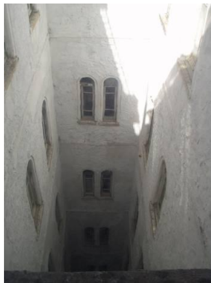
Figura 3.5: Fotografia do saguão central, vista de um piso elevado (Branco, 2006)
